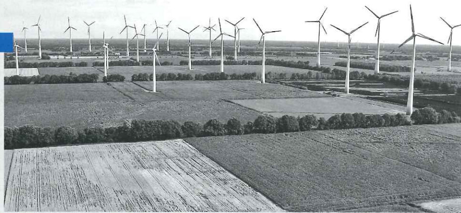
Raiffeisen Energiepark Saterland
